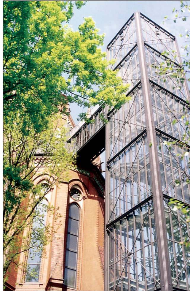
Neuer Treppenturm zur Erschließung des Dachraums der Heilig-Kreuz-Kirche in Berlin
